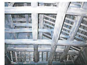
▲和小屋による小屋組(屋根裏)
